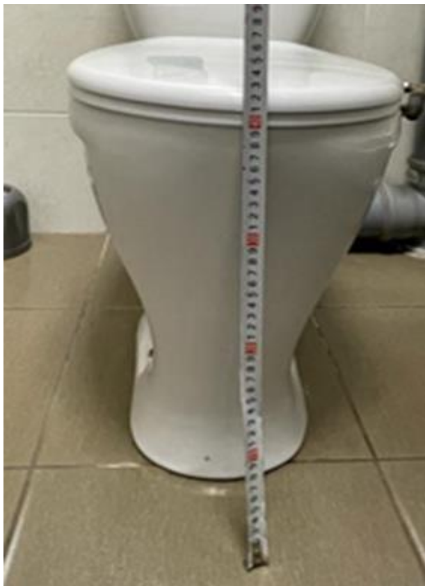
Санитарно-гигиеническое помещение. Высота унитаза – 0,40 м, высота раковины –
