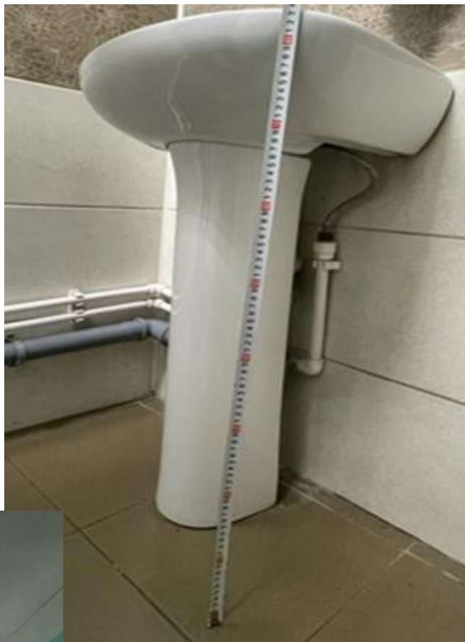
Санитарно-гигиеническое помещение. Высота унитаза – 0,40 м, высота раковины –
